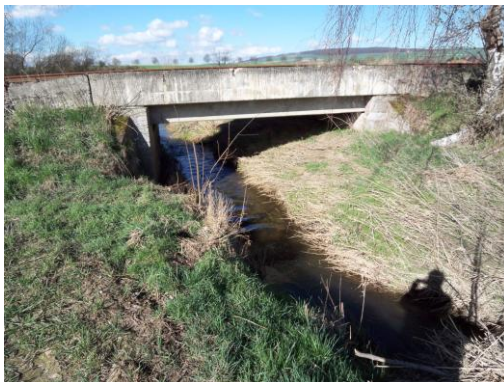
18 Brücke der Eisenbahnstrecke Derneburg / Bornum am Harz
