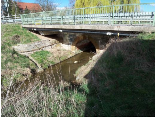
15 Brücke der Straße L 498 Volkersheim – Bockenem
