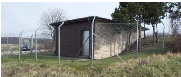
Neuer Hochbehälter am Brunkenberg
