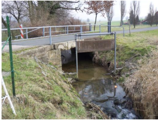
7 Brücke zum Hochstedt mit Staustufe für den Brandschutz
