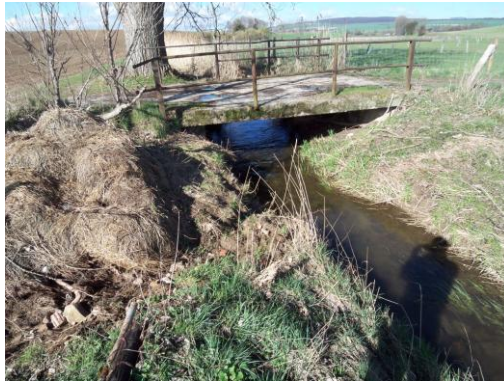
17 Brücke für einen Feldweg bei Schlewecke
