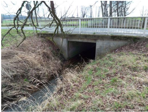
3 Brücke der Straße L 500 am Bachweg
