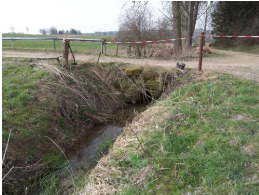
Brücke der Zufahrt zum Klostergut in Bodenstein
