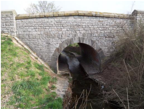
12 Brücke der Straße L500 nach Bockenem „Steinerne Brücke“
