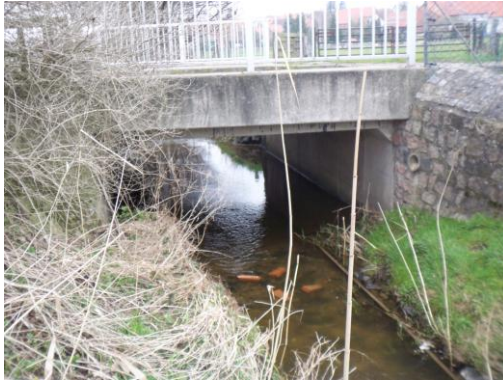
5 Brücke am Schwarzer Weg
