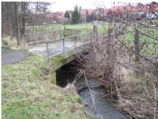
6 Brücke am Schwarzer Weg / Trafostation
