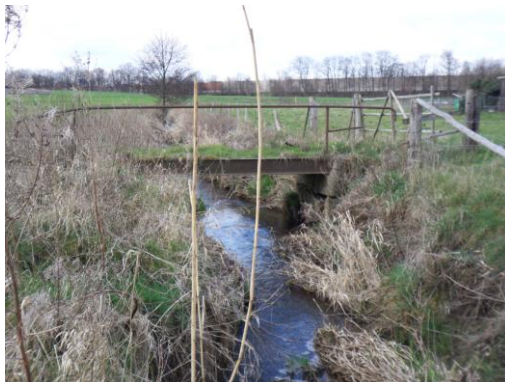
8 Alte Brücke beim Grundstück Dannenbaum
