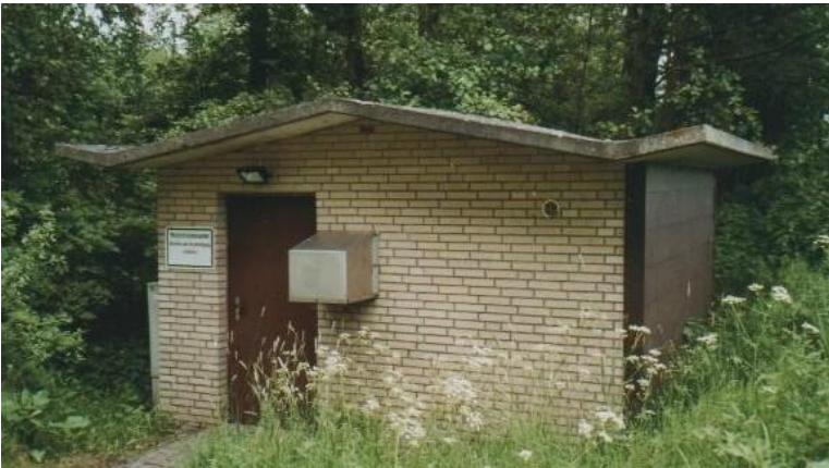
Neue Pumpstation am Schmiedeteich
