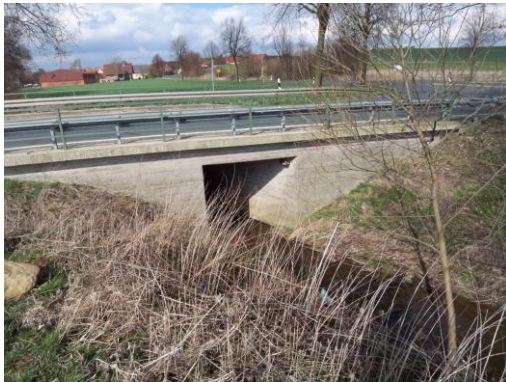
4 Brücke der Straße L 500 zur Autobahn
