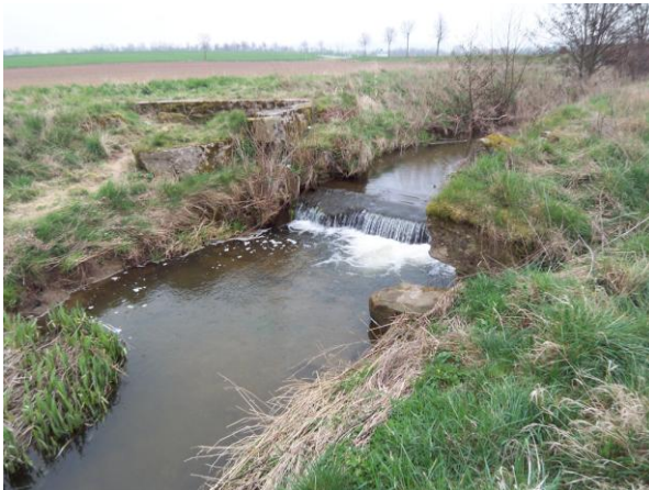
Reste vom Wehr für von Gadenstedts – Wiesen
