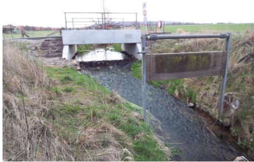
9 Brücke am Mühlenberg mit Staustufe für den Brandschutz
