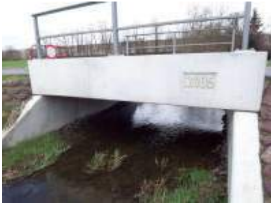
Brücke Nr.9 am Mühlenberg oberlauf
