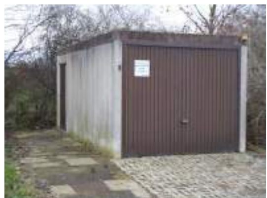
Schmutzwasserpumpstation am Bach
