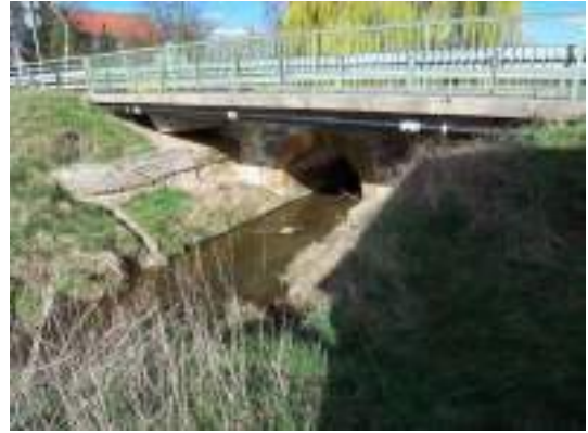
Brücke Nr. 15 an der Straße L 498 Volkersheim – Bockenem oberlauf Neue Fahrbahn auf alter Bogenbrücke
