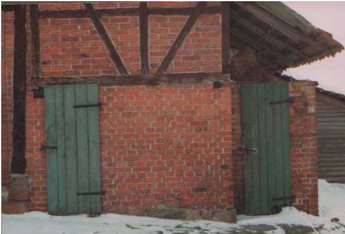
Altes Haus zum Hof Henner Wolze Braunschweiger Str. 30, 1984 (Siehe Lageplan für alte Häuser Punkt III)
