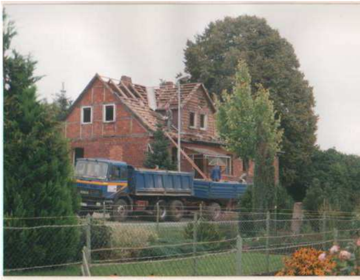
Abriss des Altenteil-Wohnhauses der ehemaligen Dampfziegelei 1998 (Siehe Lageplan für alte Häuser Punkt VI)
