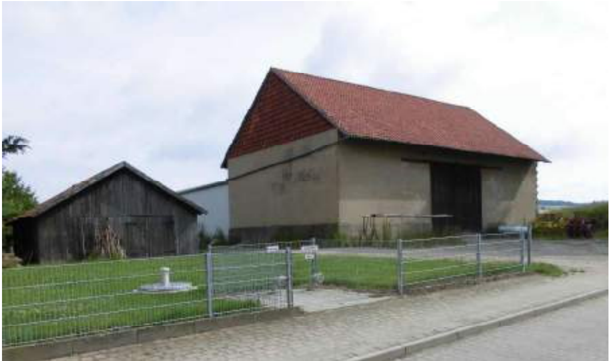
Kelpe/Münkels Scheune Ansicht Süd
