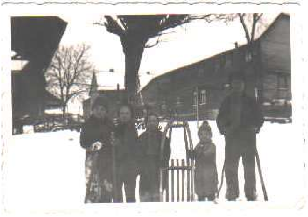
Bild Nr. 1 Im Hintergrund Haus Nr. 40, Westansicht im Januar 1941
