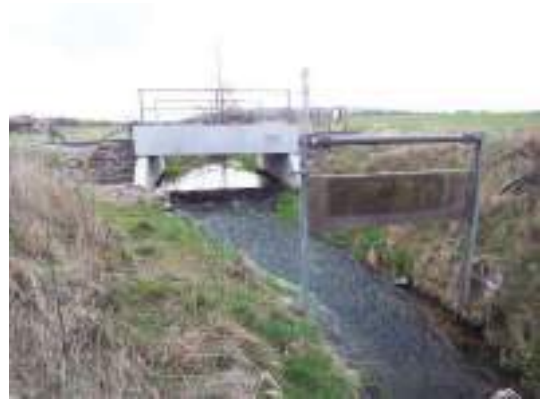
Brücke Nr.9 am Mühlenberg unterlauf
