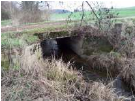
Brücke Nr. 2 zur Mergelkuhle unterlauf
