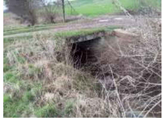
Brücke Nr. 2 zur Mergelkuhle oberlauf
