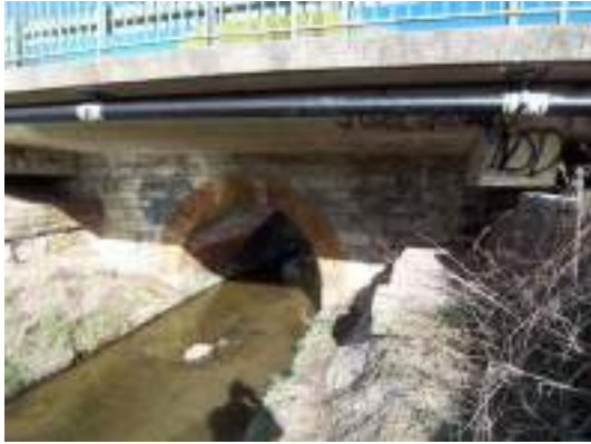
Brücke Nr. 15 an der Straße L 498 Volkersheim – Bockenem oberlauf Neue Fahrbahn auf alter Bogenbrücke
