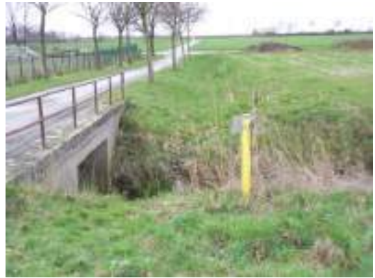
Brücke Nr. 11 zu Meyers-Hütte unterlauf mit Düker für Gasleitung
