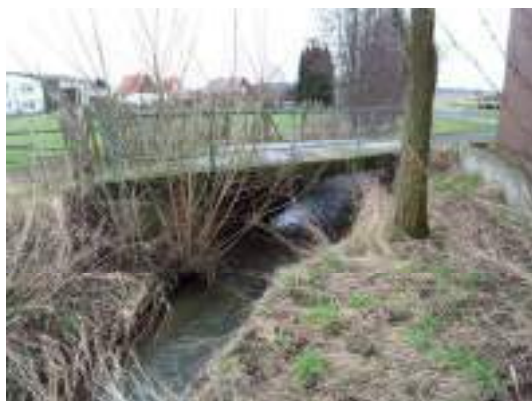
Brücke Nr. 6 am Schwarzer Weg /Trafo unterlauf
