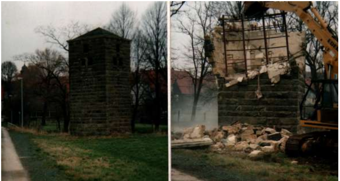
Der alte Transformator wird abgerissen
