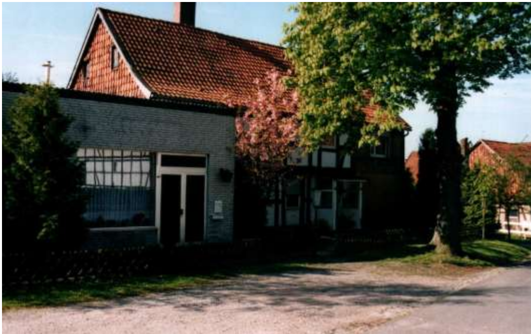
Altes Gemeindebackhaus Auf dem Platz 8
