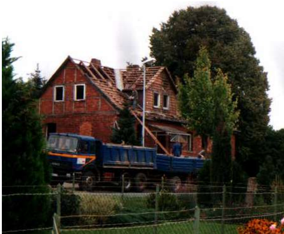
1998 Abriss des Altenteil-Wohnhauses der ehemaligen Dampfziegelei Burchard
