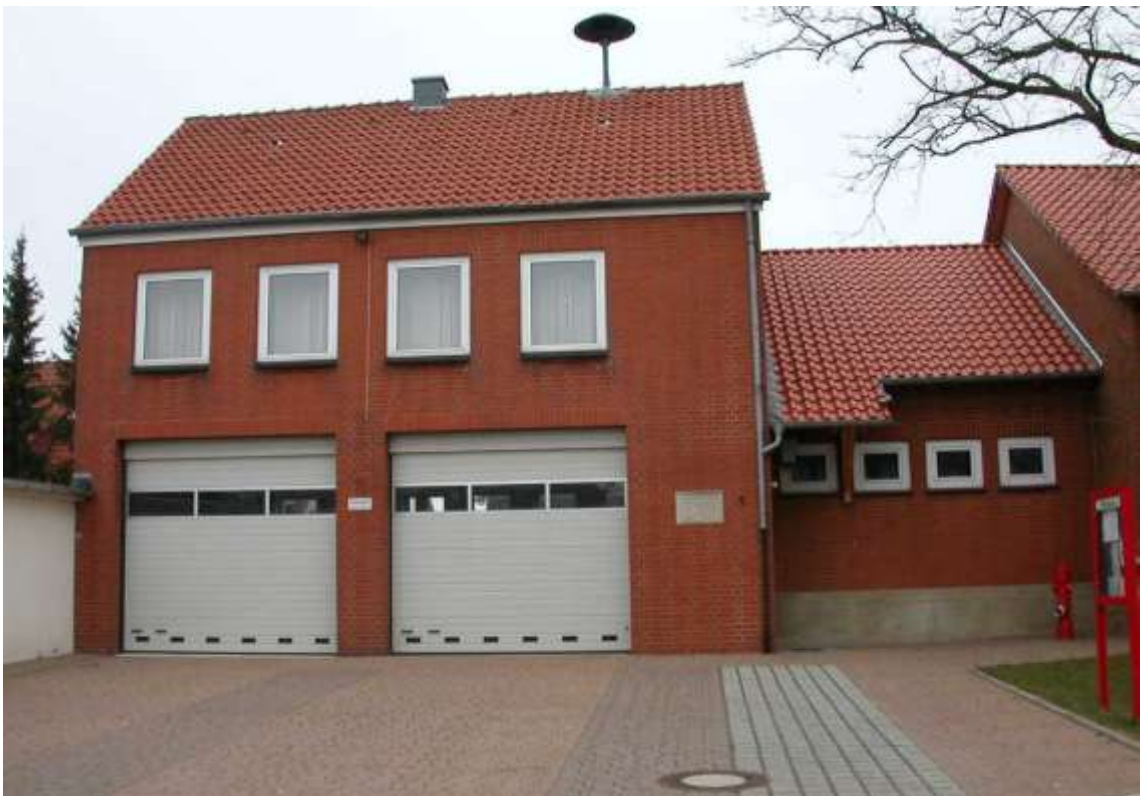
Neues Feuerwehr- Gerätehaus 2005
