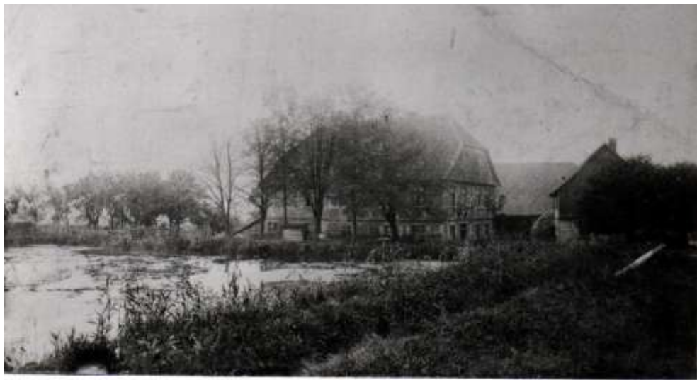
Ehemalige Dannenbaumsche Wassermühle mit Mühlenteich Mühlenberg 9
