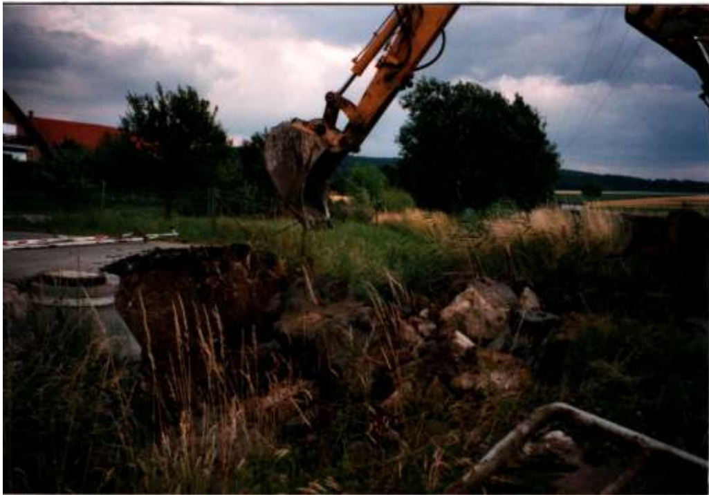
Abbruch der Bafferbrücke, die 1947 gebaut wurde
