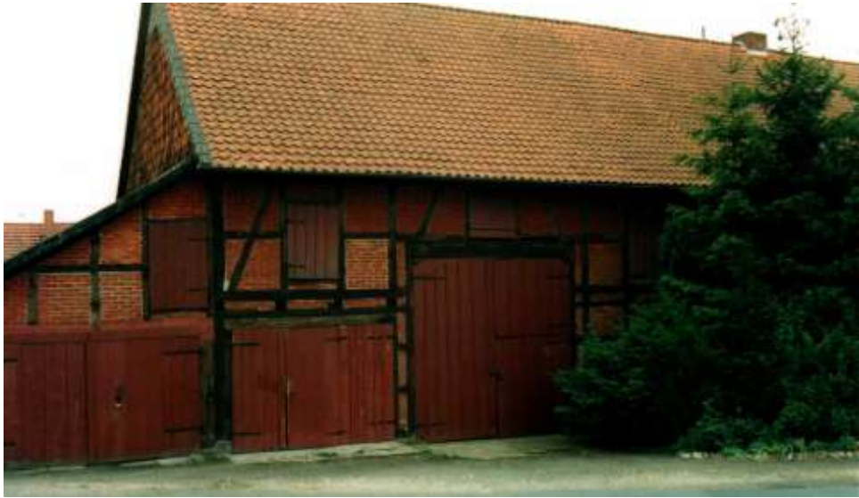
Die ehemalige Mauische Essigfabrik Braunschweiger Straße 22
