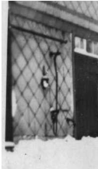
Pumpe am Haus Nr. 40 von 1942, heute Braunsch. Str. 55 Pumpe, Bild 5
